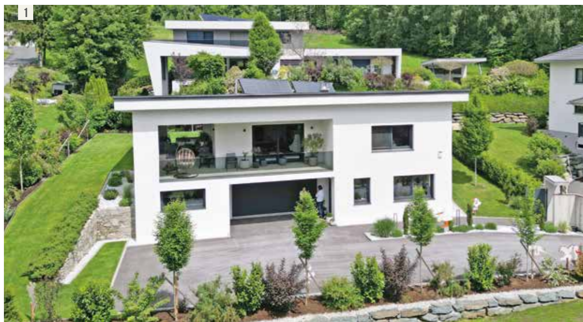
Der Neubau der Familie Höfler wird mit einer Wärmepumpe 1155-06 PC (6 kW) mit Ringgrabenkollektor von KNV geheizt und passiv gekühlt. Solarenergie wärmt die Sole vor.
